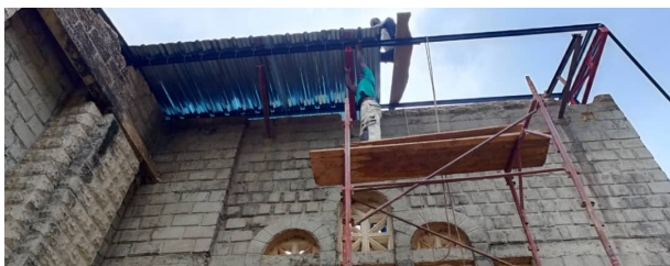
Trabajadores reparan el tejado del coro.
